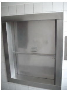
Edelstahlbelegung an einer Schachttür
